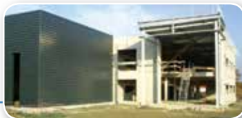
NANTES EQUIPEMENT à Ste-Luce-sur-Loire
