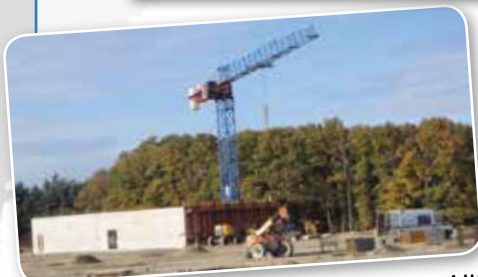
ALGAM à Carquefou, c'est parti !!! Les 1 ères élévations sortent de terre !
