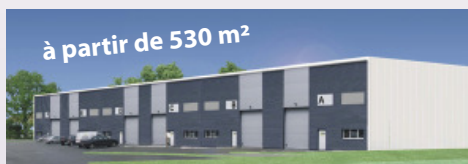
ACTIV'SUD III - Les Sorinières (44)
